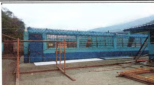
Foto1: PARTE EXTERIOR TECHO (MODULO 1)
