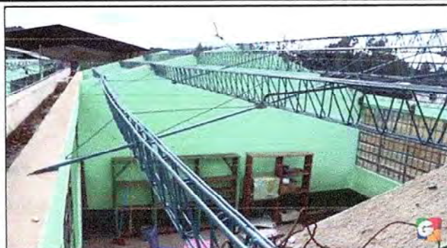
Foto 2: PARTE INTERIOR TECHO (MODULO 2)
