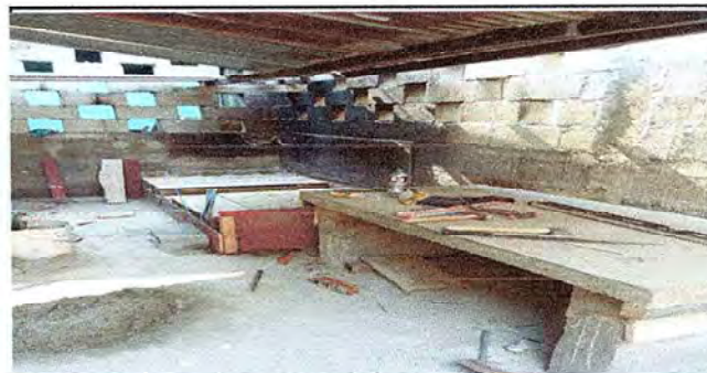
Foto 6: MODULO 3. (INTERIOR COCINA)
