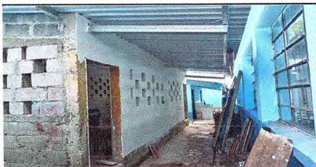
Foto 5: MODULO 3 (EXTERIOR COCINA)
